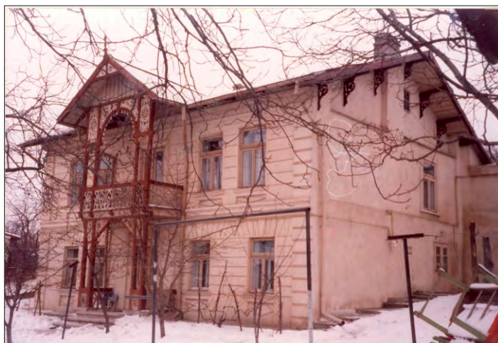
Casa Tuduri unde au funcționat, la parter, clasele Școlii nr. 4 de băieți, între anii 1867-1870. Aici a învățat Alexandru Vlahuță.
